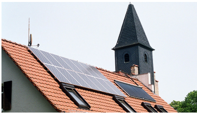
Solaranlage auf dem Kirchendach in Wandlitz (Brandenburg)
